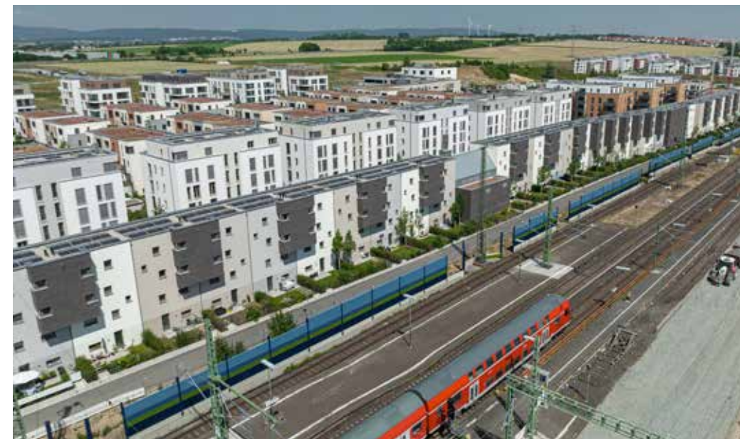
Im Quellenpark in Bad Vilbel entstand ein geschlossener Gebäuderiegel nur 14 Meter von den Gleisen entfernt.
